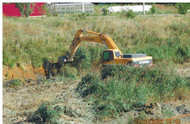
Рис. 15.40. Реконструкция (восстановление) отводящего канала водосброса Курского гидроузла на р. Тускарь
