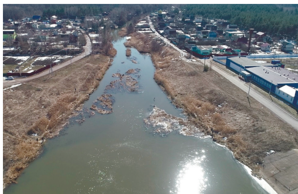
Рис. 15.39. Реконструкция (восстановление) отводящего канала водосброса Курского гидроузла на р. Тускарь
