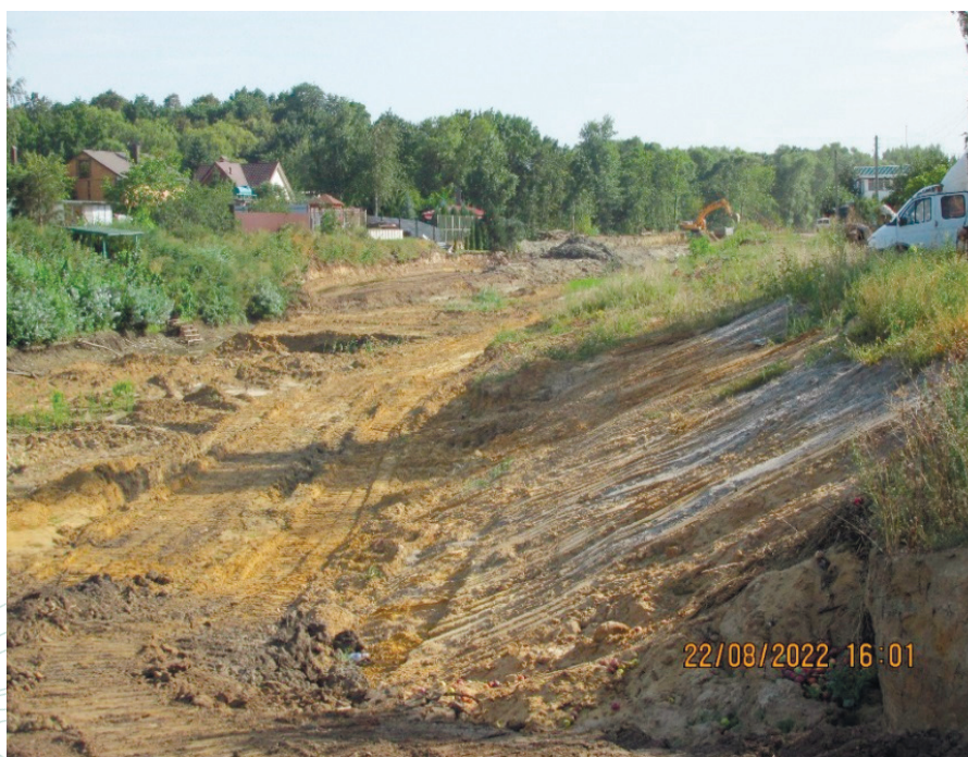
Рис. 15.41. Реконструкция (восстановление) отводящего канала водосброса Курского гидроузла на р. Тускарь
