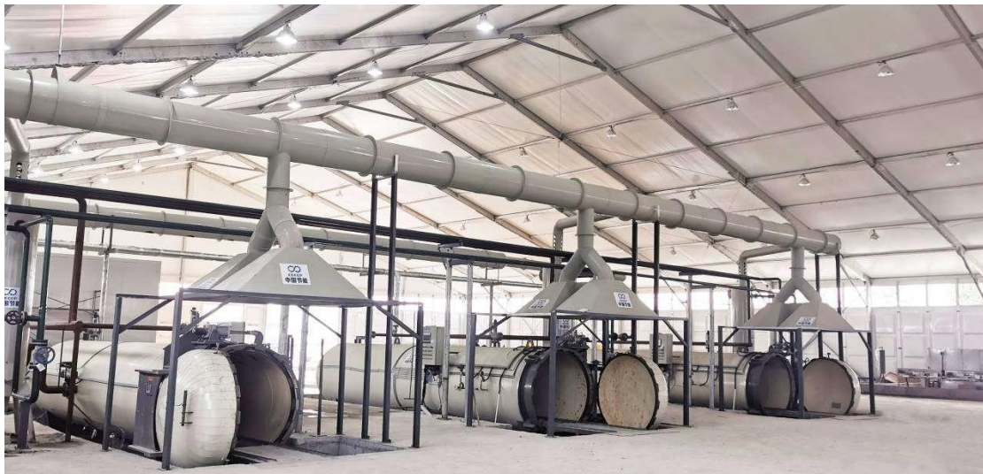
Фото: временное предприятие по обработке отходов мощностью 30 тонн в день в Ухане
