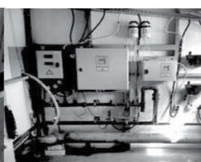
Блок анализа качества очищенных стоков по НП и ВВ
