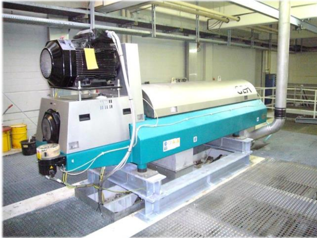
Цех мехобезвоживания с декантером (Германия)
