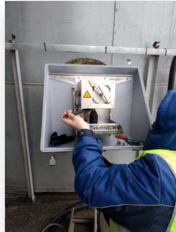
монтаж системы пробоотбора
