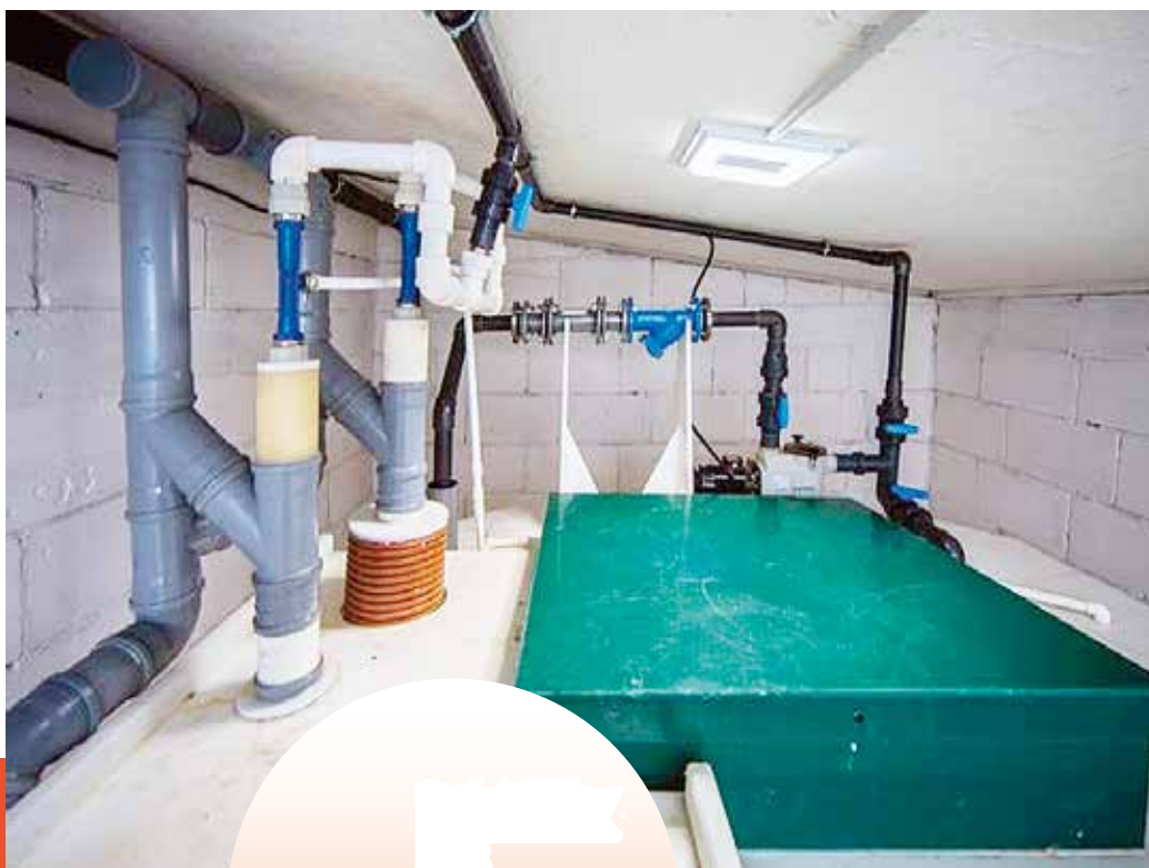
Внешние реакторные блоки модуля FEKA CLEAN pro-500
